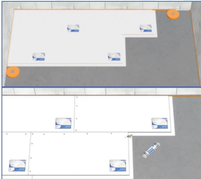
Стык вертикальный и горизонтальный двух панелей крепите саморезами для панелей 19мм.
